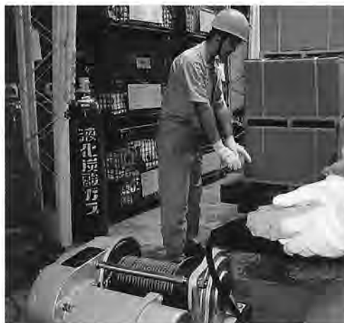
▲ 台車の牽引作業
